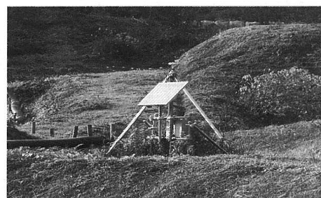
写真-1 現地 GPS 設置状況
