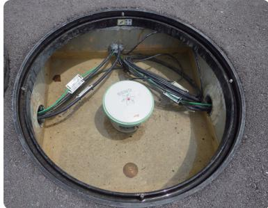
ダム堤体の変位傾向を三次元で連続的に計測
