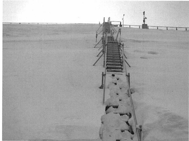
図-7 除雪用作業通路写真
