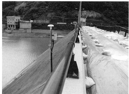
図-2 GPS 設置写真
